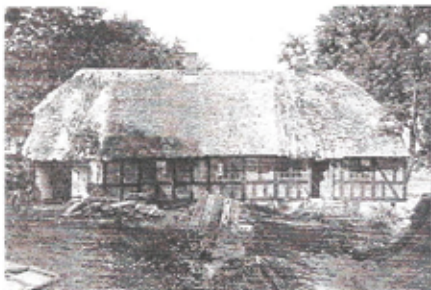
ESKES HUS I ALLING
