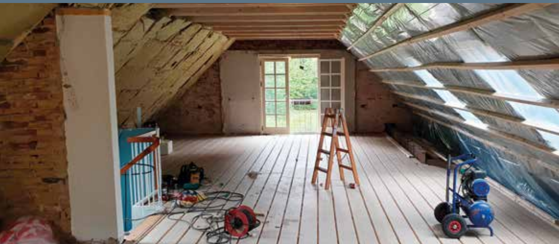
Loftsrummet gjort klart til genopbygning
